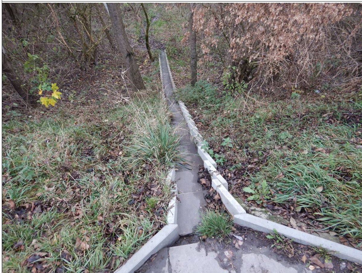
Odwodnienie osuwiska (2022)
